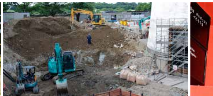
プロローグ空間増築のための掘削。[平成29年7月]
