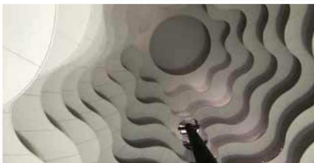
組み立て中の水平線(太陽の空間)。[平成29年9月]
