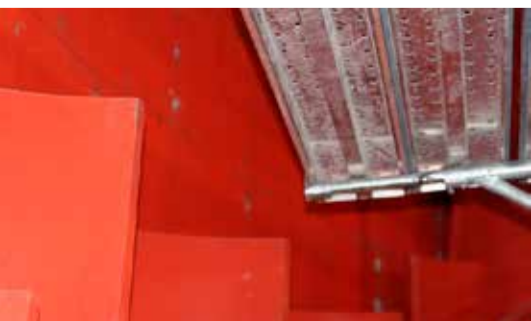
拡散板（コロナ）の取り外し。[平成28年12月]
